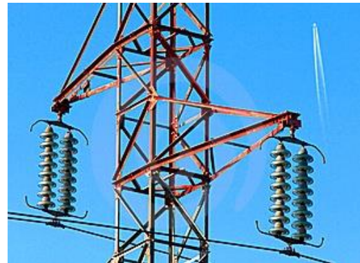
Cadena de suspensión con cuernos de descarga Figura 1.4.19
