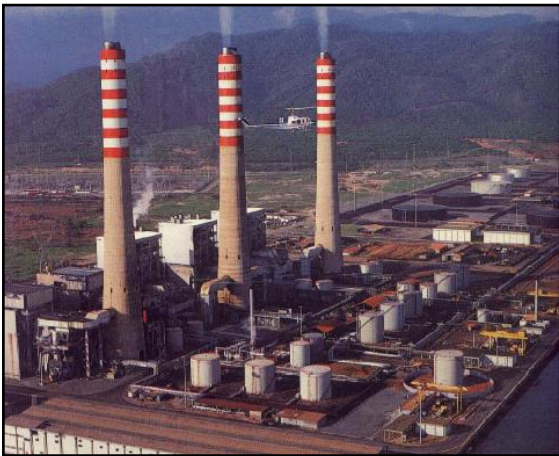
Generación termoeléctrica Figura 1.1.4
